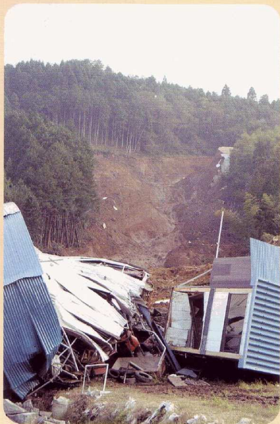
台風23号の大雨により発生した地滑り (=養父市八鹿町幸陽区、平成16年10月22日撮影)
