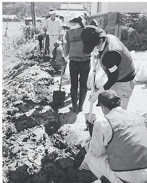
▲水害のあった家の前に溜まった泥を土嚢袋につめ、運び出す作業を行うボランティア（＝9月21日、興地区道路）
