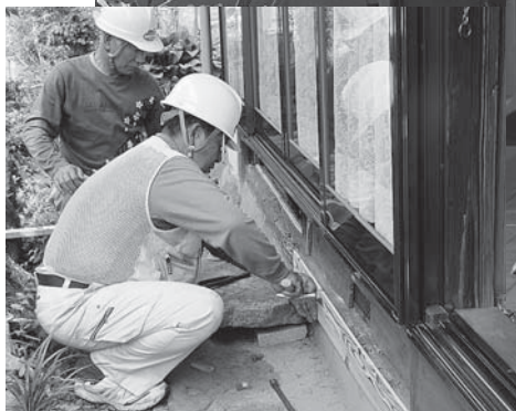
▲縁の下の換気孔網を取り替え、板を打ち付けて補強
